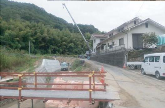
砂防河川(新庄町) 仮橋設置、施工状況
