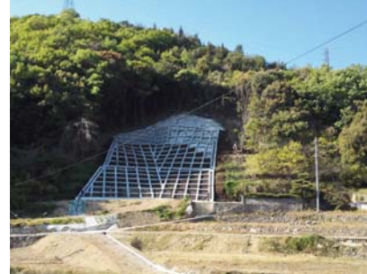
▲復旧工事中(施工:(有)竹親建設)
