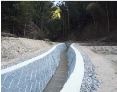
▲復旧(施工:川西組)
