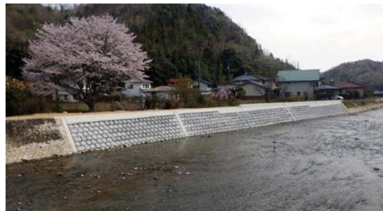
▲本復旧(施工 株繁光組)
