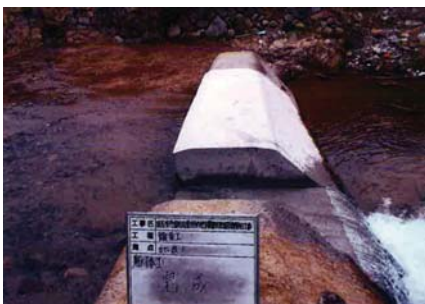
▲復旧(施工:株イワノ)
