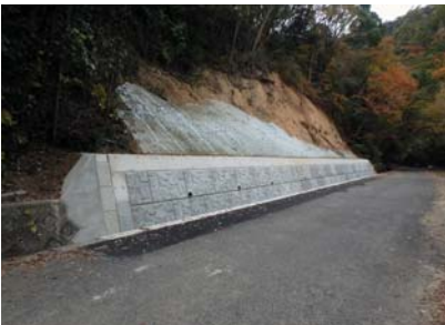
▲完了(施工 平原建設(株))
