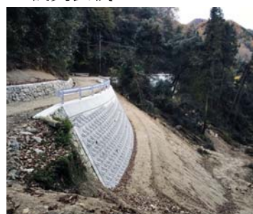
▲一部完成(施工 川西組)
