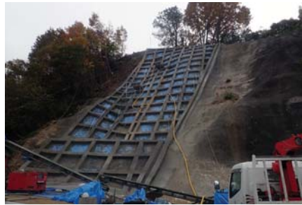
▲施工中(施工 保手浜建設(株))
