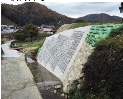
▲復旧完了(施工 (株)青木建設)
