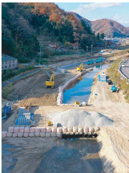
▲広島県施行 賀茂川護岸災害復旧工事 (施工 沖元土建(株))
