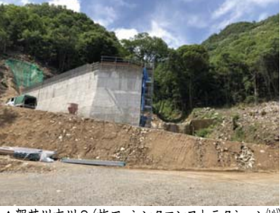
▲賀茂川支川8(施工:シンクコンストラクション(株))
