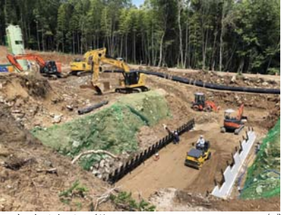
▲賀茂川支川7(施工:シンクコンストラクション(株))
