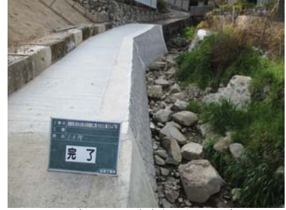
▲復旧(施工:株)名栄工業
