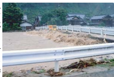
→ 賀茂川 水ノ口橋 (平成30年災害時)
