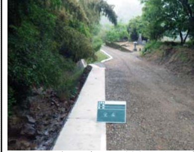
▲復旧工事中(施工:(有)悠栄建設)
