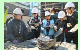
屋根瓦修理体験
