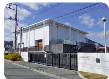
竹原市中央第2 雨水排水ポンプ場
