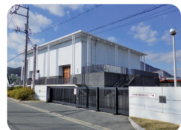
竹原市中央第2 雨水排水ポンプ場
