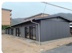
改修した市営住宅 （第2丸子山住宅B棟）
