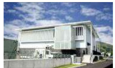
竹原市中央第2雨水排水ポンプ場
