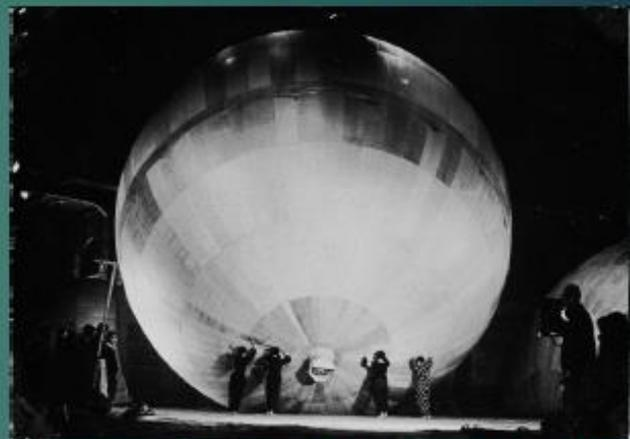
画像:風船爆弾(気球)の製造工程における機密度検査
