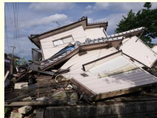
平成28年4月熊本地震での住宅被害(益城町)
